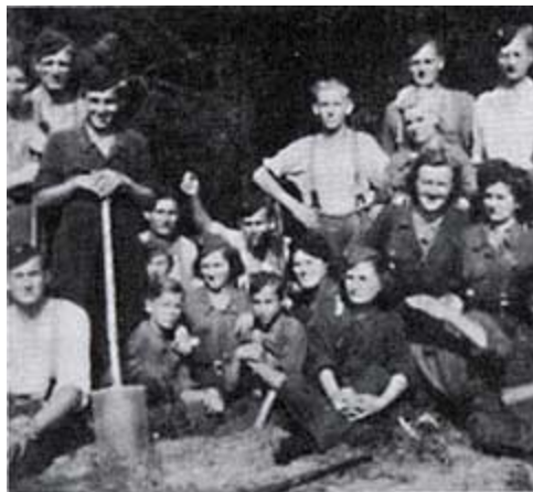
Будівництво гнізд під зенітні устави
